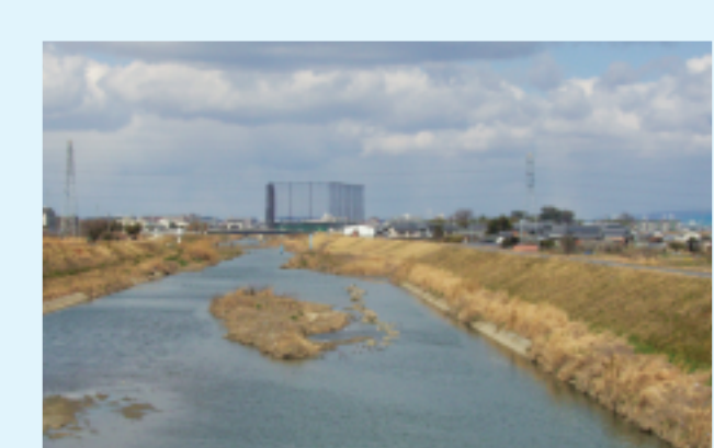
井筒橋から上流をのぞむ
